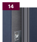
14 Uszczelka pęczniąca (drzwi PPOŻ)
