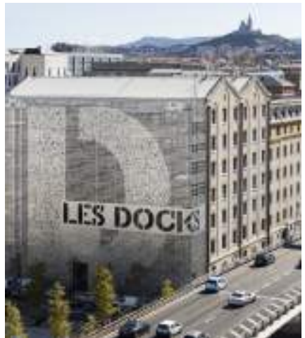
Marseilles Docks, Marseille/France (2009-2015)
