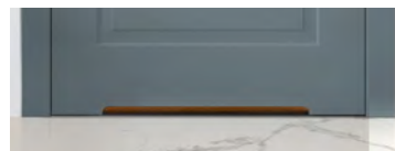
Podcięcie łazienkowe, wys. od podłogi 19 mm
